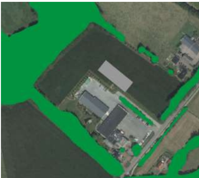
Ligging van het plangebied, inclusief projectie van de nieuw te bouwen hal. Met de groene kleur wordt de bestaande beplanting aangeduid.
