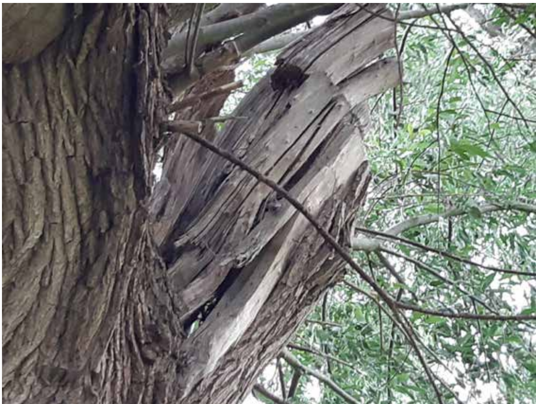
Scheuren in uitgebroken arm van één van de wilgen. De scheuren zijn tochtig, er vormen zich geen echte ruimtes.
