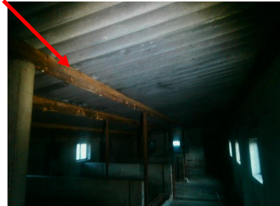
Foto 4 | Golfplaten op het dak
