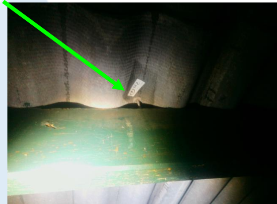
Foto 6 | Golfplaten op het dak
