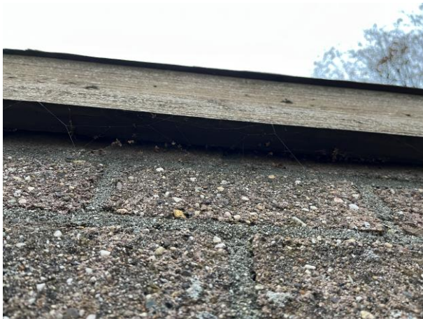
De daklijsten sluiten strak aan op de buitengevels.
