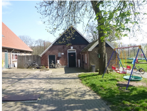
Berging zuidzijde Deurningerstraat 222
