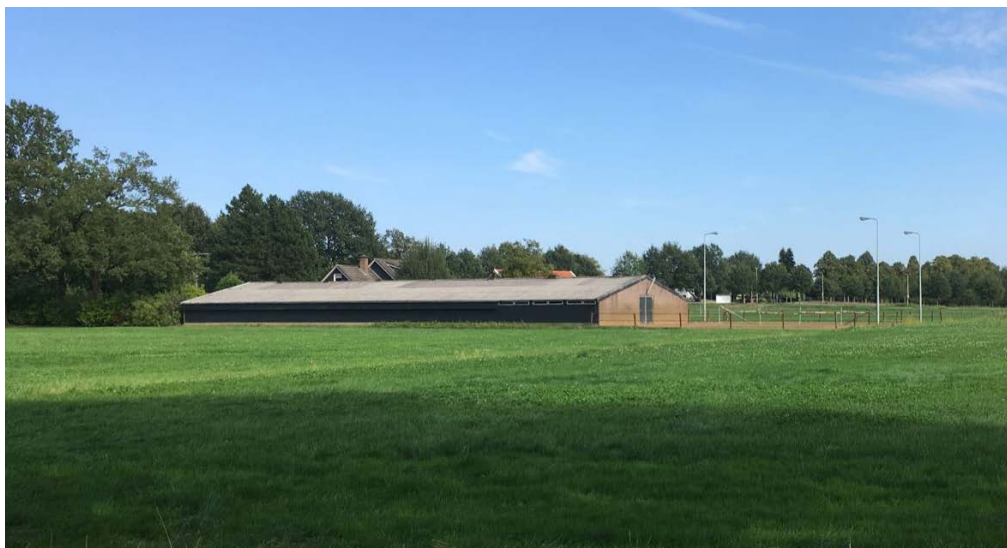
Figuur 3 De te verwijderen schuur - Ootmarsumsestraat 43
