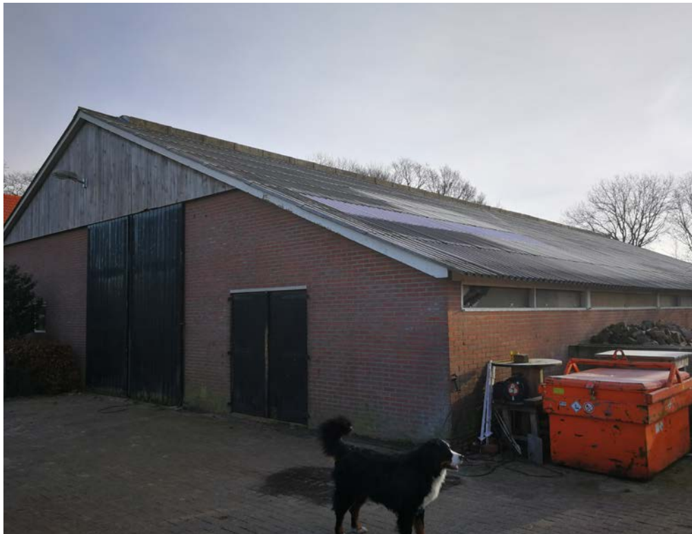
Figuur 6 De te verwijderen schuur - Westerhoekweg 10
