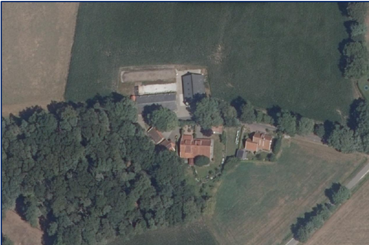
Figuur 2.1: huidige situatie Enktermorsweg te Agelo (bron: ruimtelijkeplannen.nl)
