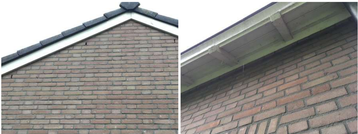
Foto links: open stootvoegen in de buitengevel. Deze zitten allemaal vol spinrag waardoor ze niet gebruikt worden als invliegopening voor vleermuizen. Foto rechts: het gebouw is goed afgewerkt, zo is de verbinding van de gevel met het dakvlak dicht zodat vleermuizen niet de spouw of de zolder kunnen betreden.
