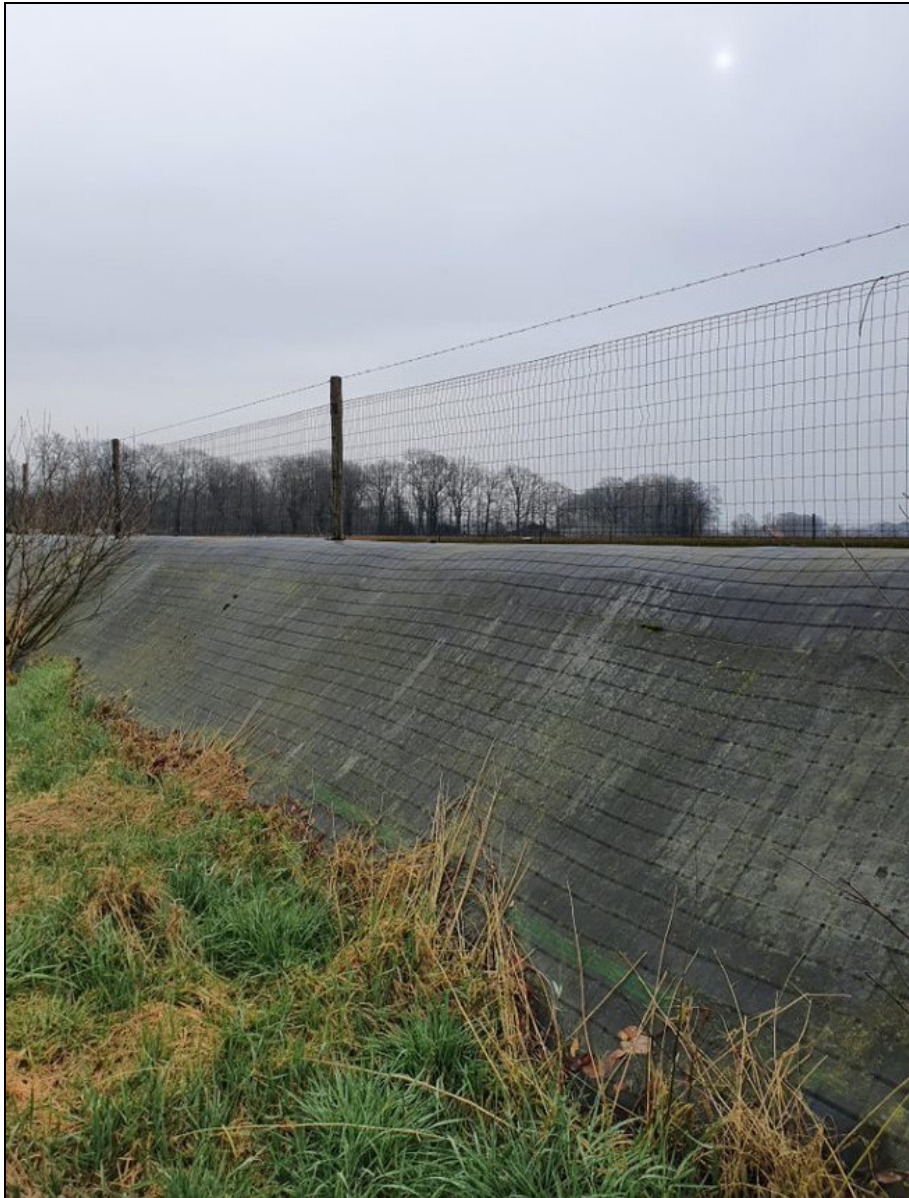
Afbeelding 7: Bestaand waterbassin en hekwerk
