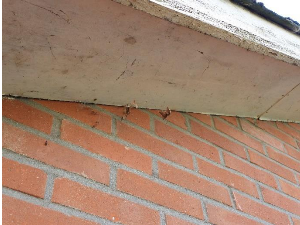
De betimmering van de overstek van het dak sluit naadloos aan op de buitengevels.
