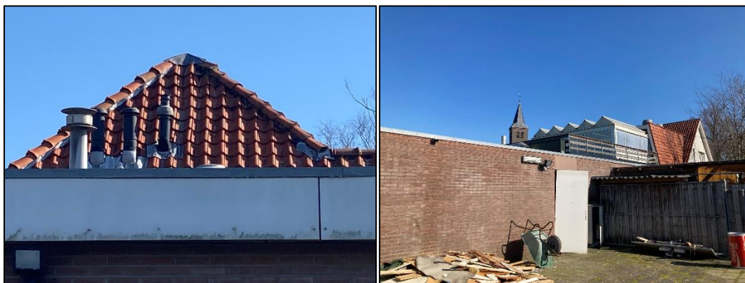
Figuur 2.2 (links): Het puntdak behorende bij de zolder; Figuur 2.3 (rechts): Een blik op de zuidzijde van de bebouwing, met de serre op de eerste verdieping.
