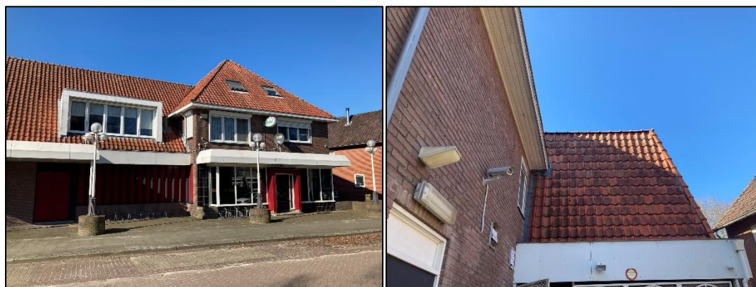
Figuur 2.2 (links): De bebouwing gezien vanaf de straatzijde. Het gebouw heeft hier een pannendak met dakkapellen; Figuur 2.3 (rechts): Aan de oostzijde bevindt zich een garage met een ingang, waarnaast ventilatieroosters te zien zijn.
