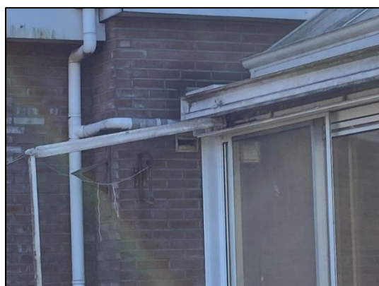
Figuur 6.5: Open ventilatieschacht in het plangebied.
