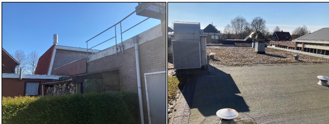
Figuur 2.2 (links): De noordzijde van de bebouwing wordt begrenst door de tuin van de naastgelegen woning; Figuur 2.3 (rechts): Het dak aan de westzijde.
