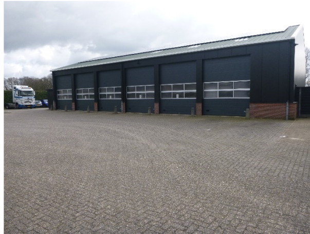
Huidige bedrijfshal gebouwd in 2005
