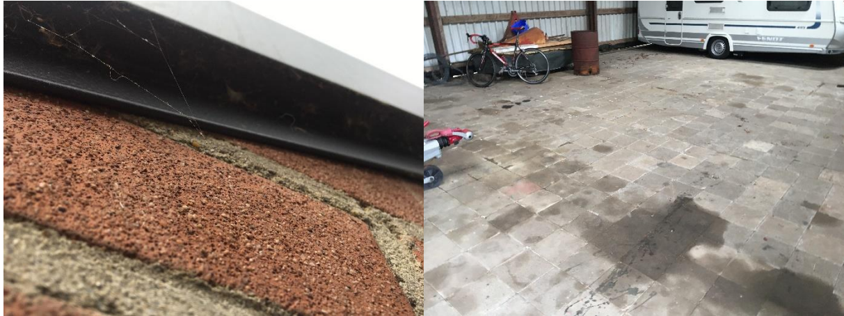
Foto links; de stalen windveren sluiten strak op elkaar aan waardoor er geen kieren ontstaan. Foto rechts; er zijn geen uitwerpselen gevonden in de toegankelijke bebouwing.
