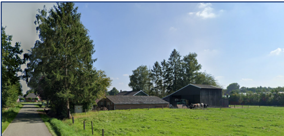
Figuur 2.2: Aanzicht Vlijertsdijk 1 Deurningen (bron: Streetview, google, sept. 2021).
