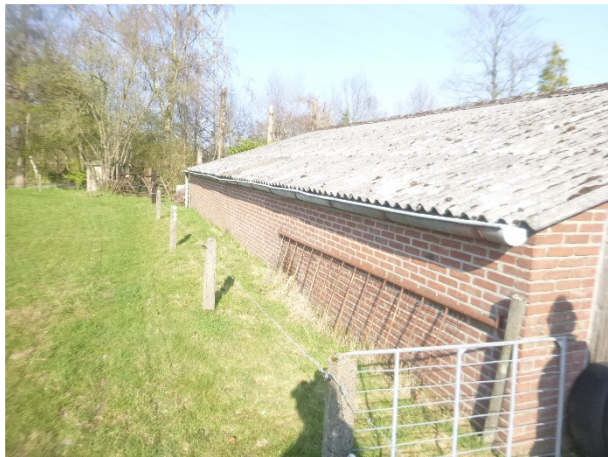
Dakgoot westzijde schuur
