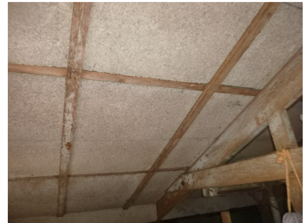
Aftimmering dak binnenzijde schuur
