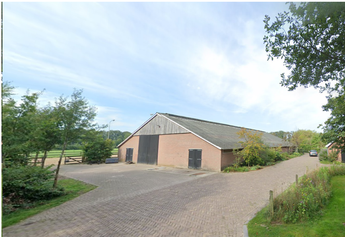
Figuur 2.6: Huidige situatie bestaande schuur (Bron: Google Maps)
