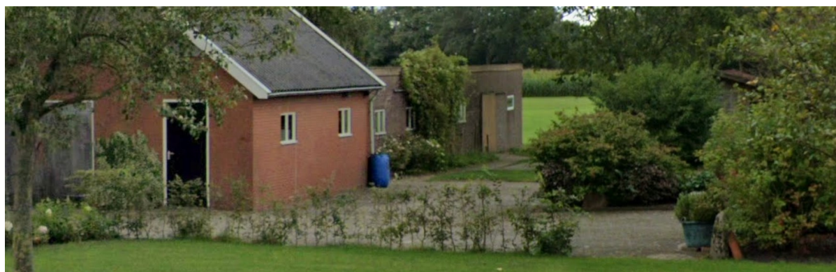
Figuur 2.6: Achtergelegen astbesthoudende landschapsontsierende bebouwing Laagsestraat 70 (Bron: Google Maps)
