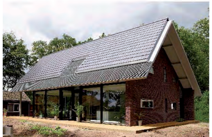
Schuurvorm met grote hoge ramen voor zicht
