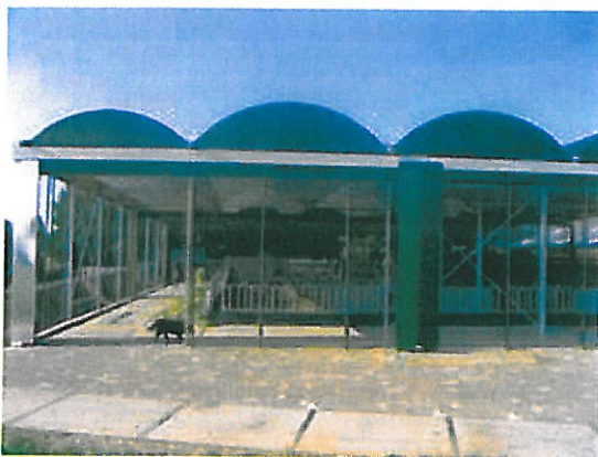
Symmetrie in de hoofdvorm van de kopse gevels
