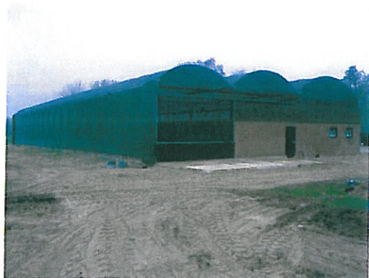
Technische installaties in de stal oplossen
