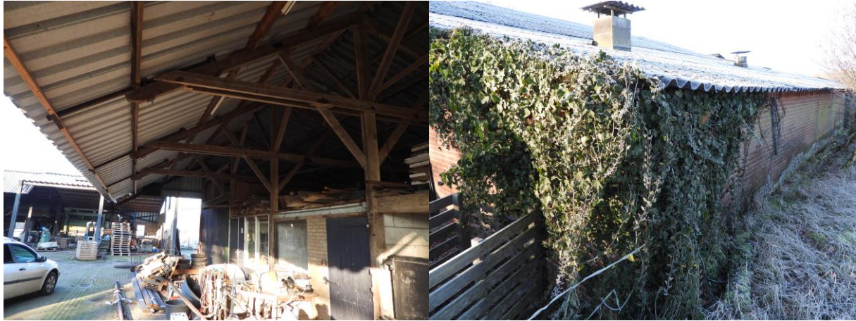
Impressie van de te slopen bebouwing.
