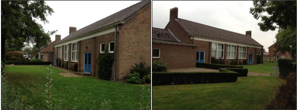
Afbeelding 2.5: Het gedeelte van het gebouw dat wordt gesloopt
