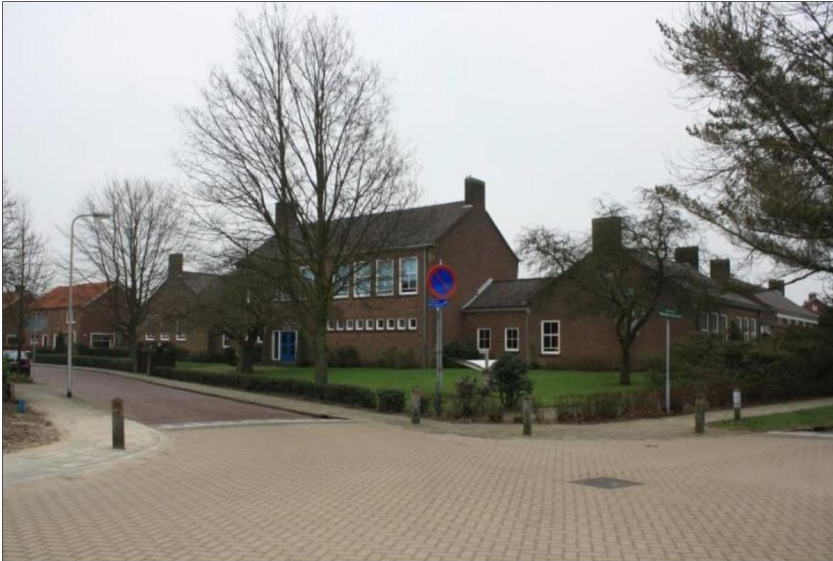
Afbeelding 2.3: Het te behouden deel van het voormalige schoolgebouw (Bron: Leferink Architecten)
