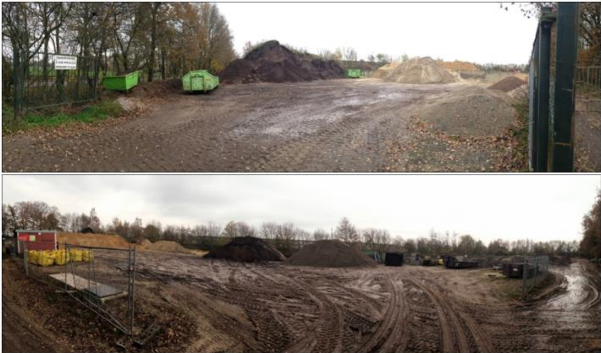
Afbeelding 2.4: Foto's huidige situatie ter plaatse van het opslagdepot
