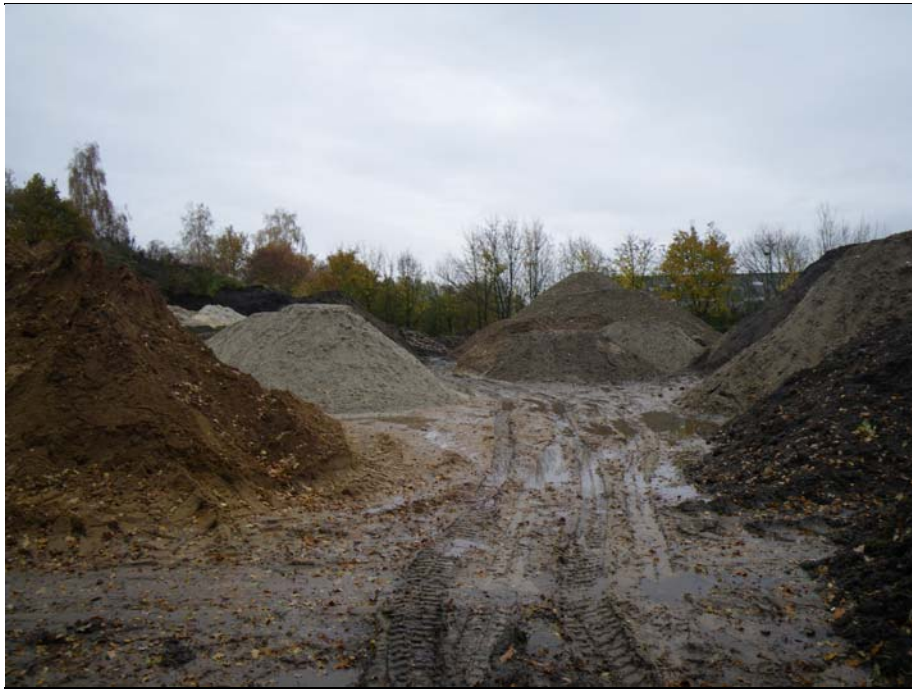
Foto b6.3 Ter hoogte van diepe boring 1 en 2, kijkrichting: oost
