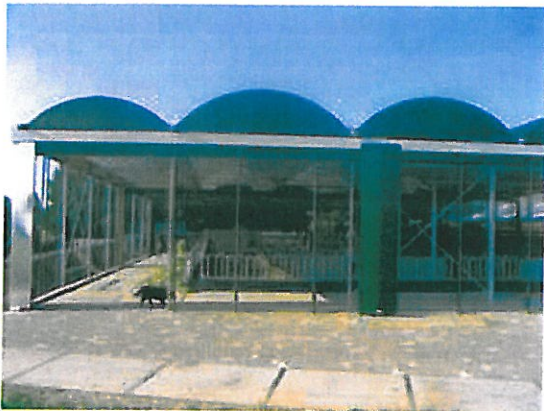
Symmetrie in de hoofdvorm van de kopse gevels
