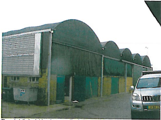
Eenduidigheid in de gevelindeling, details wegwerken
