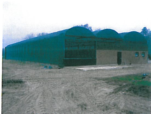
Technische installaties in de stal oplossen
